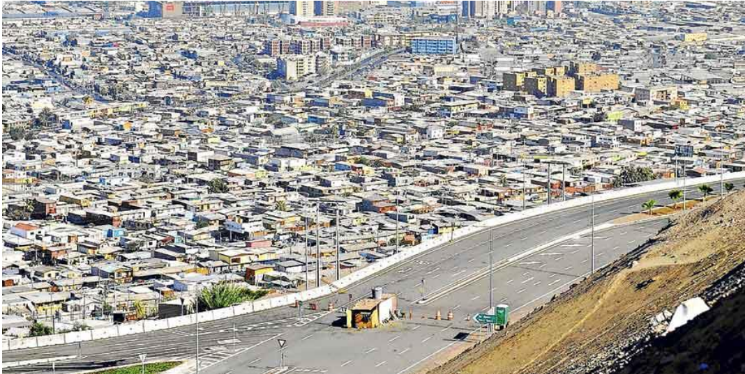
FOTOGRAFIA 4.5.1. Segundo acceso Iquique-Alto Hospicio en la Tercera Etapa de Construcción.
