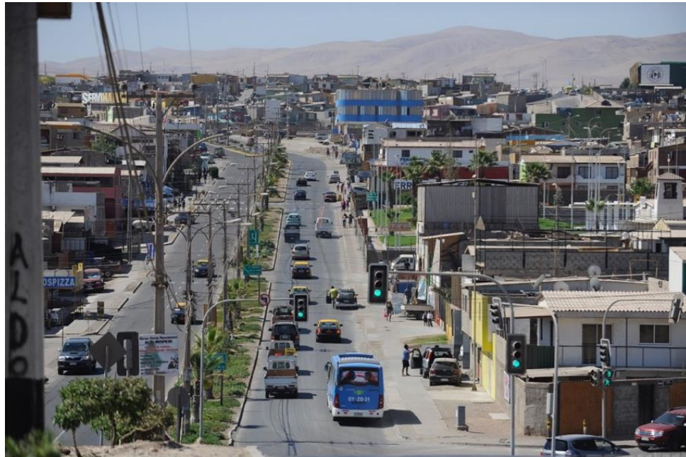
FOTOGRAFIA 4.3.2.2.1. Avenida Las Américas. La Pampa, hacia ruta A-16.
