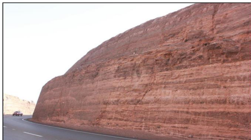
Fig 1. Gravas de Alto Hospicio en vía que conecta Iquique con Alto Hospicio (Ruta 16). Se observa la alternancia de niveles de gravas gruesas y materiales finos muy bien laminados con numerosas grietas rellenas de depósitos finos y/o materiales salinos.
